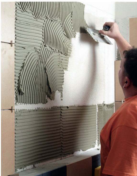
Abb. 4. Angewandte Nanotechnik: Mit einer speziellen Kombination aus Füllstoff und Bindemittel bildet dieser Fliesenkleber Nanostrukturen aus, welche die Fliese besonders stark auf dem Untergrund festhalten. (Foto: Degussa)
